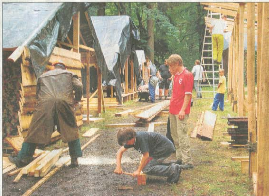
Jungpontoniere am Werk: Schritt für Schritt entsteht auf dem Gelände der Creabeton AG in Einigen ein Westerndorf.
