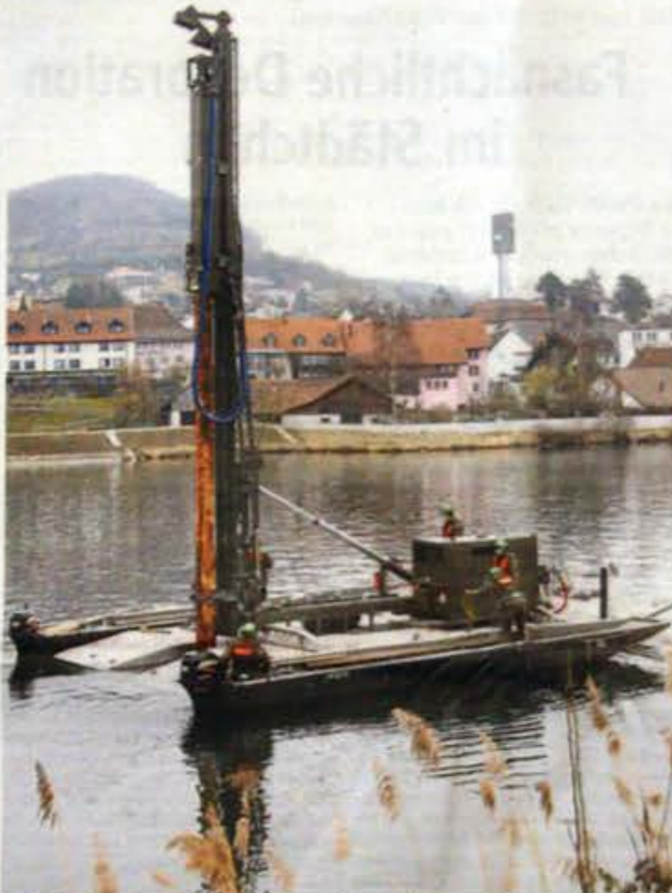
Am Donnerstag rammen die Armeeangehörigen die ersten Holzstämmen in den Aareboden.
