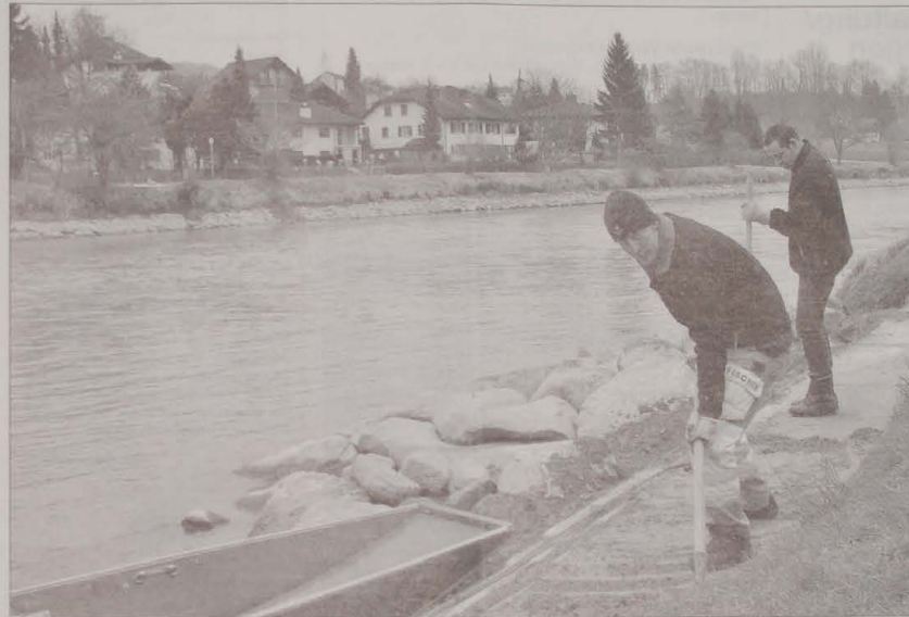
Der Spatenstich für die Arbeiten zur Pontonier-SM in Mellingen erfolgte vor einigen Tagen durch Bau-Chef Marcel Keusch (im Vordergrund) und Michael Höhn. Foto: zVg
