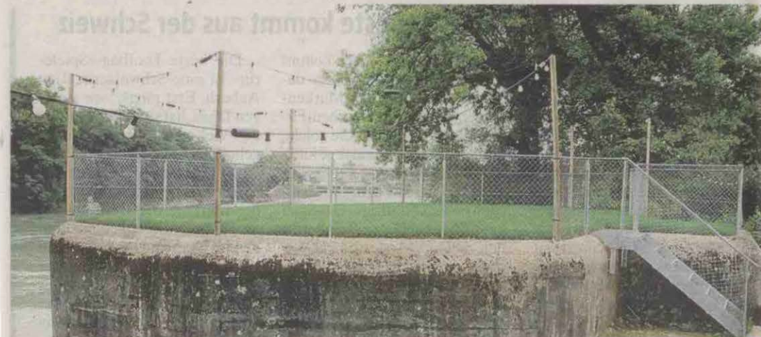
Zurzeit für das Pontonierfest vom 16./17. August geschmückt: Wahrscheinlich der einzige Schweizer Bunker mit Grasdach – und Blick aufs Kraftwerk der Radag.
