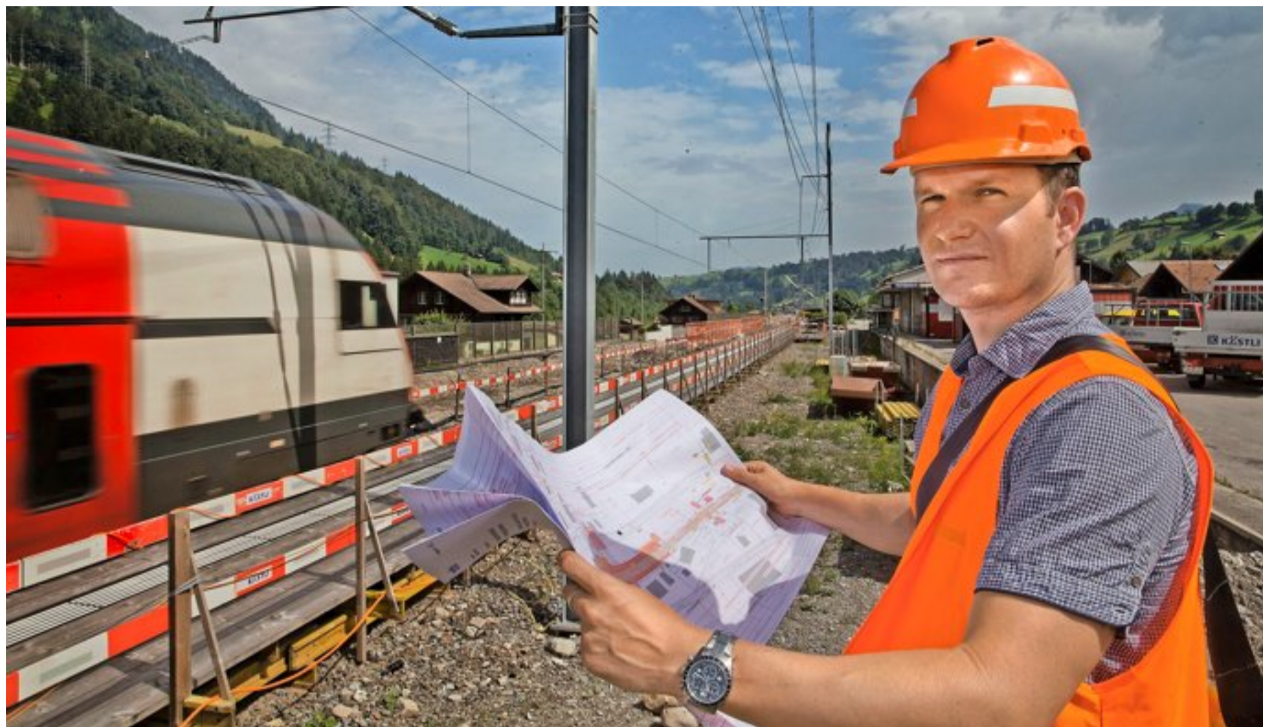
BLS-Projektleiter Marco Habegger erklärt, was auf der grossen Baustelle beim Bahnhof Reichenbach alles neu gebaut wird.
