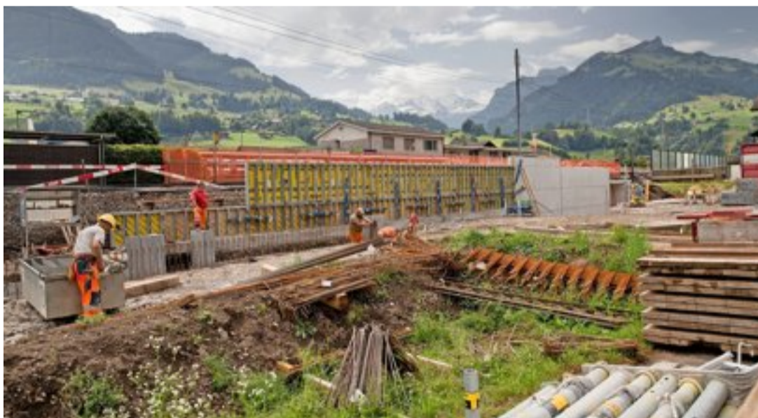
Hier werden die Betonarbeiten für die Kander-seitige neue Treppe und die Rampe vorbereitet.
